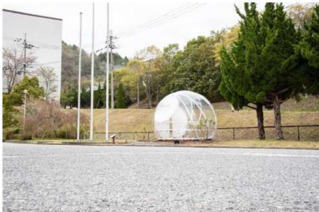
篠山工場敷地内に設置したスイス館モニュメント
